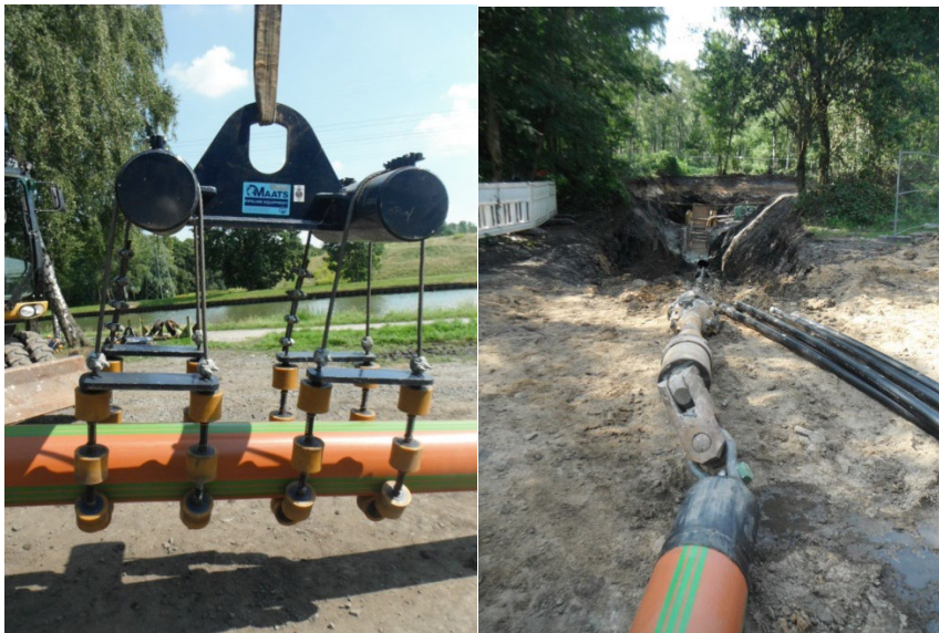
Abbildung 20: Rohreinzug ins Bohrloch (Quelle: Westnetz)
