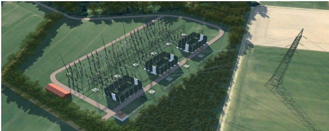
Abbildung 7: KÜS mit drei Kompensationseinrichtungseinheiten, inkl. Schallschutz (3D-Animation)
