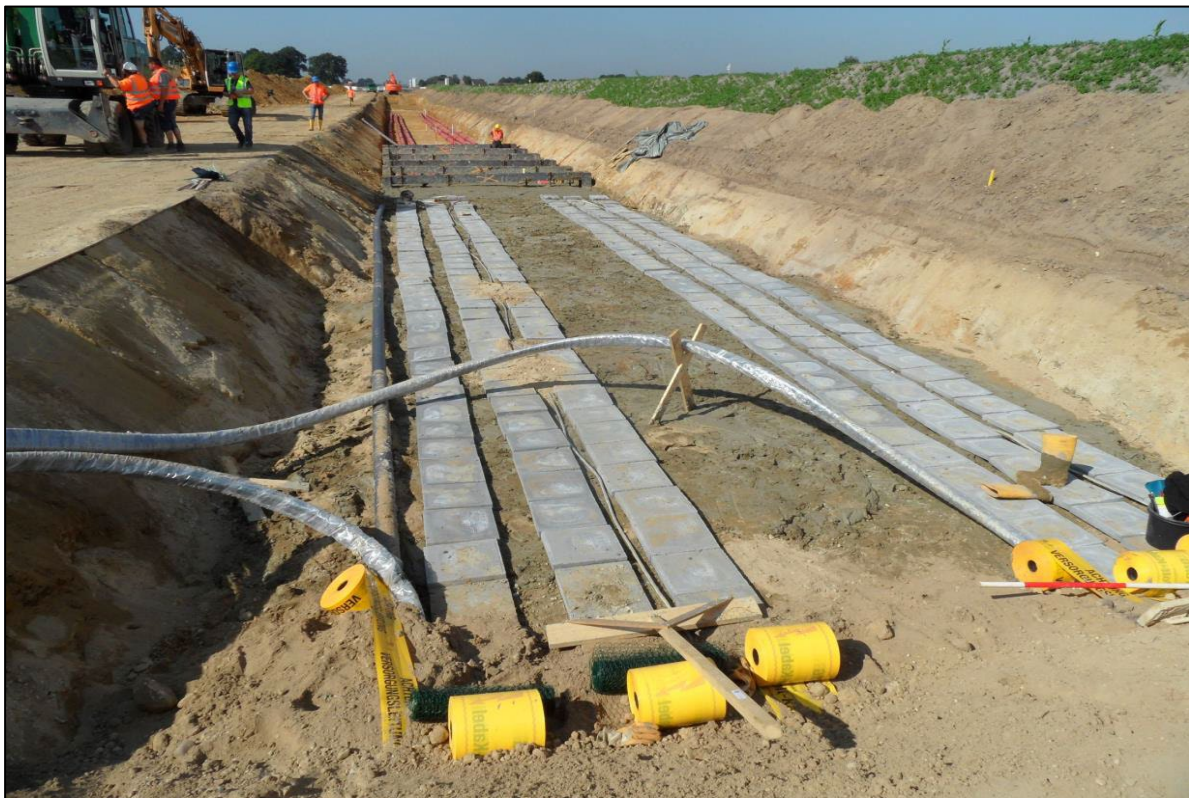
Abbildung 9: Kabelpilotstrecke der Amprion GmbH in Raesfeld (Schutzrohre bereits eingebaut und abgedeckt)
