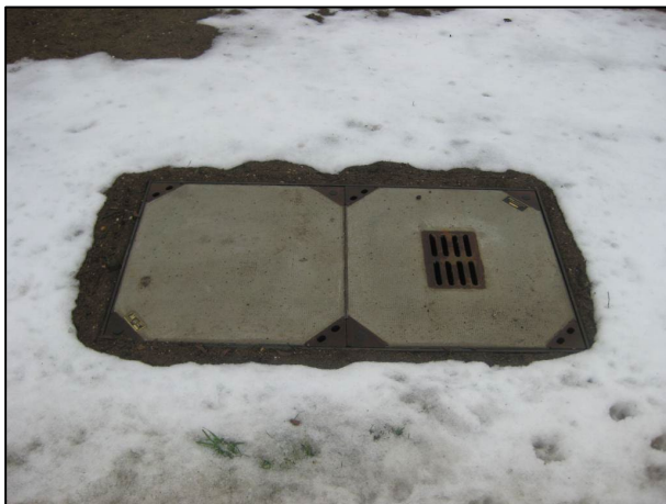
Abbildung 13: Beispiel-Foto eines Crossbondingschachts
