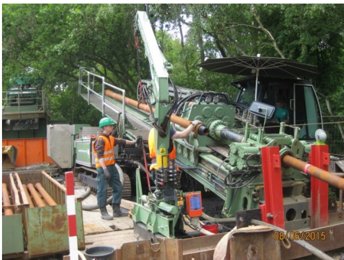
Abbildung 19: Bohranlage (Quelle: Westnetz)
