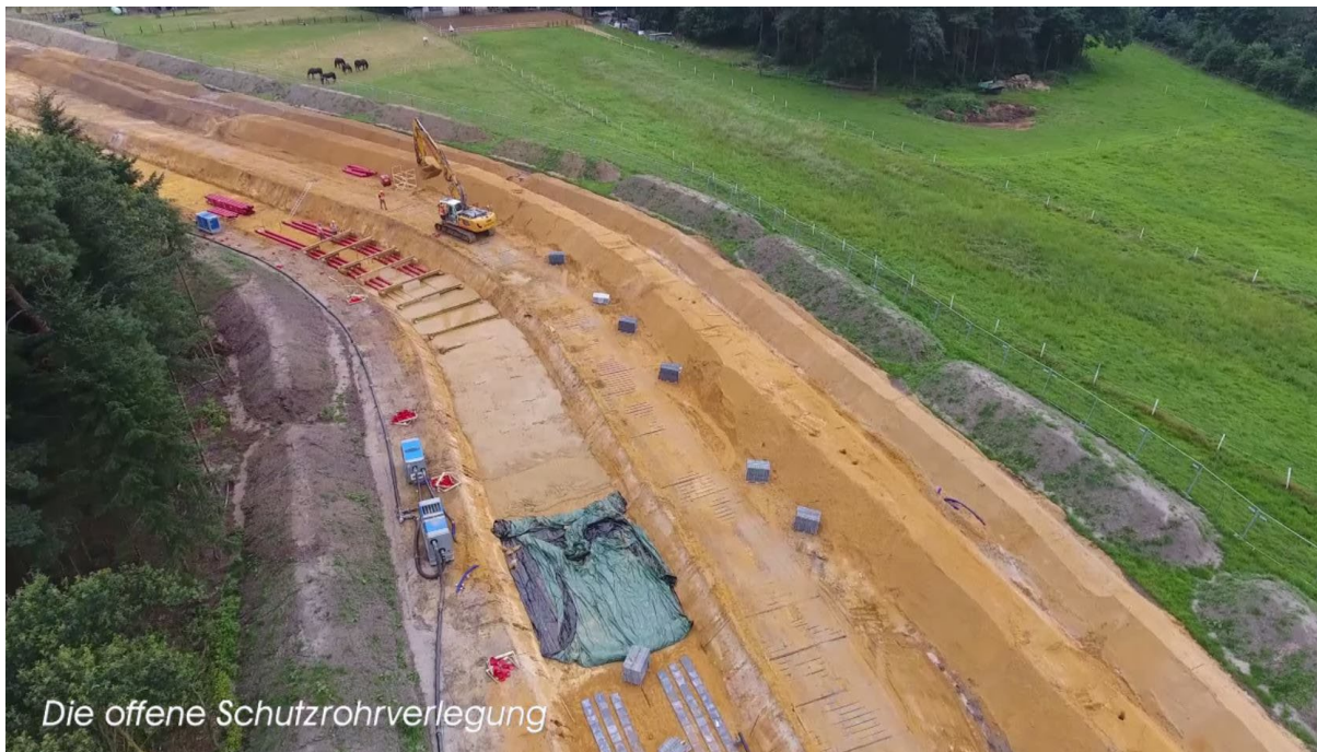
Abbildung 10: Erdkabelverlegung: Offene Bauweise (Kabelgraben mit einzelnen Arbeitsschritten)
