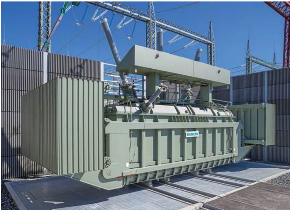
Abbildung 6: Kompensationsanlage Drossel
